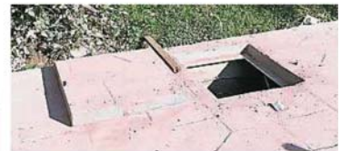
行人道设洋灰排水沟盖，以免垃圾掉落入沟渠内。
